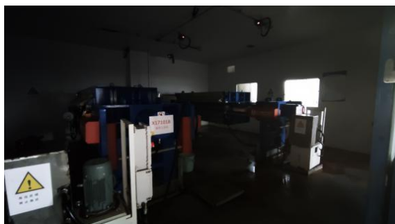
现有密闭压滤间内部
