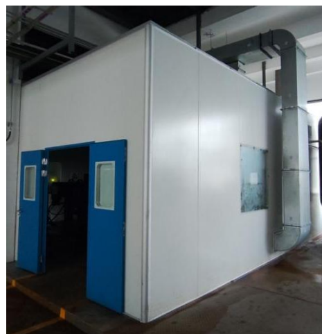
现有密闭压滤间外部
